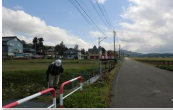
作業写真（5月作業分）
