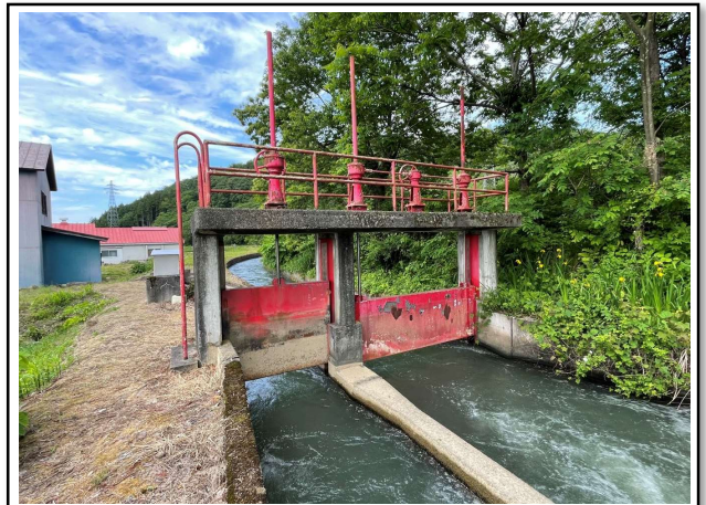
▲ 上新保地内 背割れ分水ゲート
