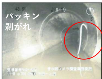
▼ ▲ 地下管路破損状況
